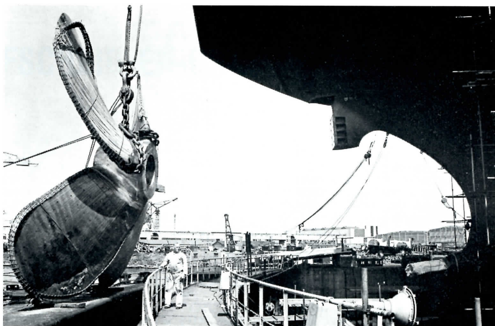
Eind juli is de schroef van het m.s. „Neverita“ op de schroefas gemonteerd. Op bovenstaande foto ziet u de schroef gedurende het transport door een drijvende bok. De schroef, die door „Lips“ werd vervaardigd van „cunical bronze“, heeft een gewicht van 24.705 kg en een diameter van 6.700 mm.
